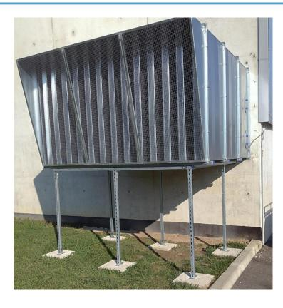
L'émergence sonore générée par l'usine de Rosny était supérieure à la limite fixée par la règlementation. Lors de visites conjointes avec dB Vib Consulting, nos équipes ont identifié les sources prédominantes et imaginé les solutions de traitement permettant de réduire l'émergence sous le seuil réglementaire. Ce type d'organisation permet d'allier une bonne connaissance technique ainsi qu'une expertise acoustique afin d'ajuster la solution aux objectifs fixés par les organismes de contrôle.
