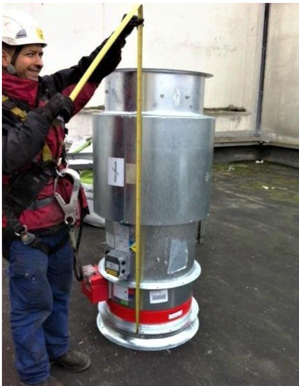
ENEDIS, à travers son service dédié aux postes sources (BRIPS), a choisi dB Vib Ingénierie pour réaliser le remplacement du système de ventilation du poste source de Turgot (18e arr). Ce chantier est l'un des premiers d'une grande campagne de rénovation des postes Parisiens intramuros.
