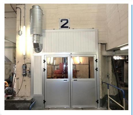
L'Usine de MARCILLAC fait partie du GEH de CHASTANG et comprend 2 groupes. Le groupe 1 entrant dans une longue période de maintenance et de rénovation, EDF souhaitait **traiter acoustiquement le groupe** 2 afin de permettre aux opérateurs travaillant dans l'usine de le faire avec un **confort** suffisant.
